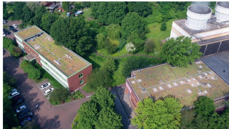
Gründächer bei GMVA in Oberhausen
