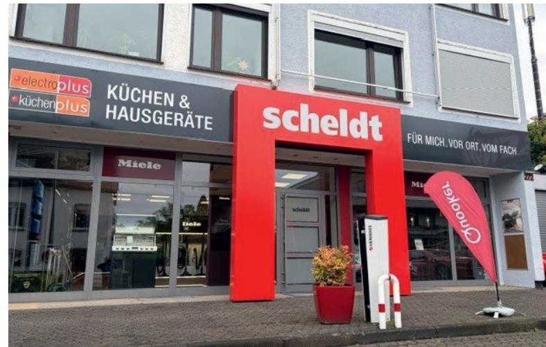
Klimatisiertes Ladengeschäft von Elektro Scheldt in Rösrath-Forsbach
