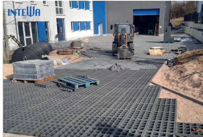
Hofsanierung mit Regenwasserversickerungssystem bei Intewa
